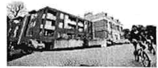
Een nieuwbouwproject van Serviceflats Invest in Kontich. foto: svh
